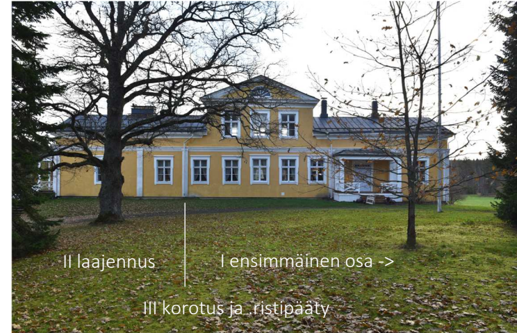
Kuva: Loukion päärakennuksen pohjoisjulkisivu.
