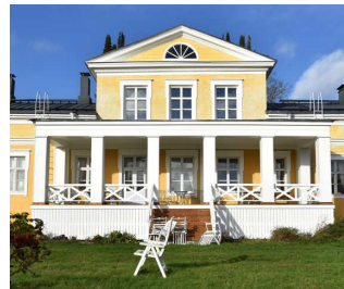
Kuva: Pilarien uusi jyrkevä ilme on tehty levyverhouksella. Kaitteessa pystysäle on vaihtunut ristikkoon.
