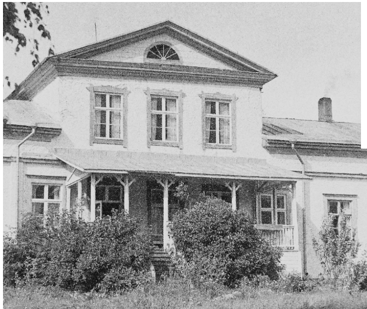
Kuva: Loukion kartanon eteläjulkisivu. Viimeisen peruskorjauksen yhteydessä on yläkerran ikkunoiden vuorilaudat yhtenäistetty alakerran ikkunoiden tyyliksi. / Kuvaaja vänrikki K. Sjöblom 1944 . Sotamuseo. SA-kuva. CC BY 4.0.
